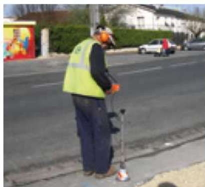
Réalisation d'une écoute au sol (source : Irstea)
