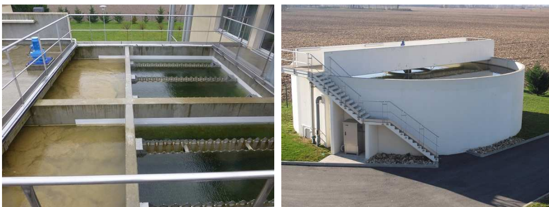
Usine de Calmont (SPE Hers Ariège)
