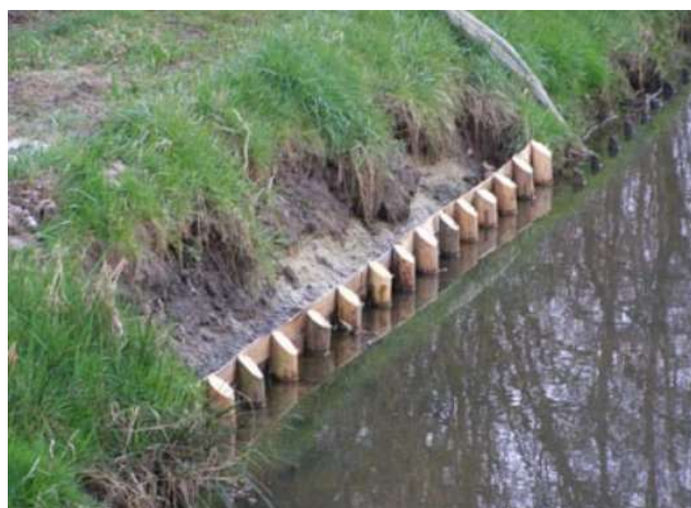
Figure 11. Exemple de tunage végétal (Source : notre planète.info : Palplanches-bois (ou tunage-bois-crédit : Titico)
