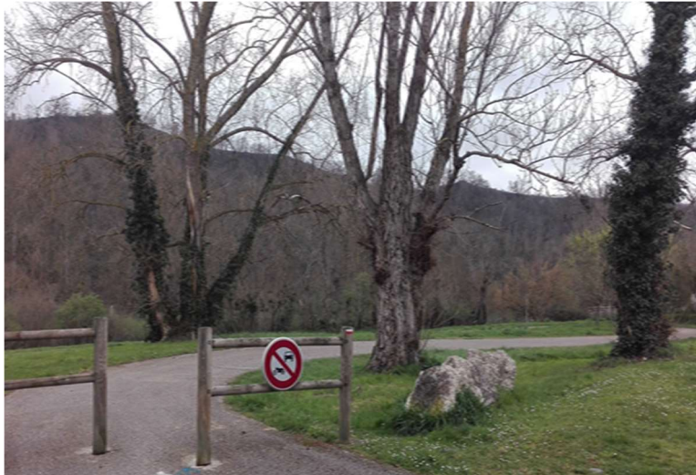
Figure 17. Exemple d'aménagement « anti-intrusion » (Source : Conseil départemental de la Haute-Garonne)
