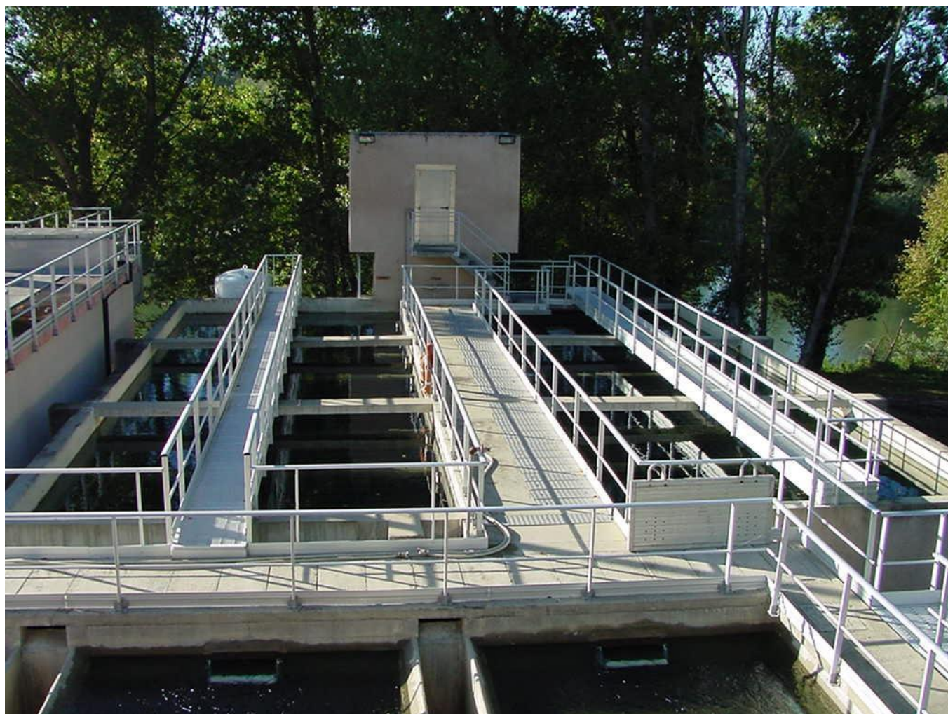
Illustration 19 : Bassin décanteur de l'usine de production d'eau potable de VieilleToulouse
