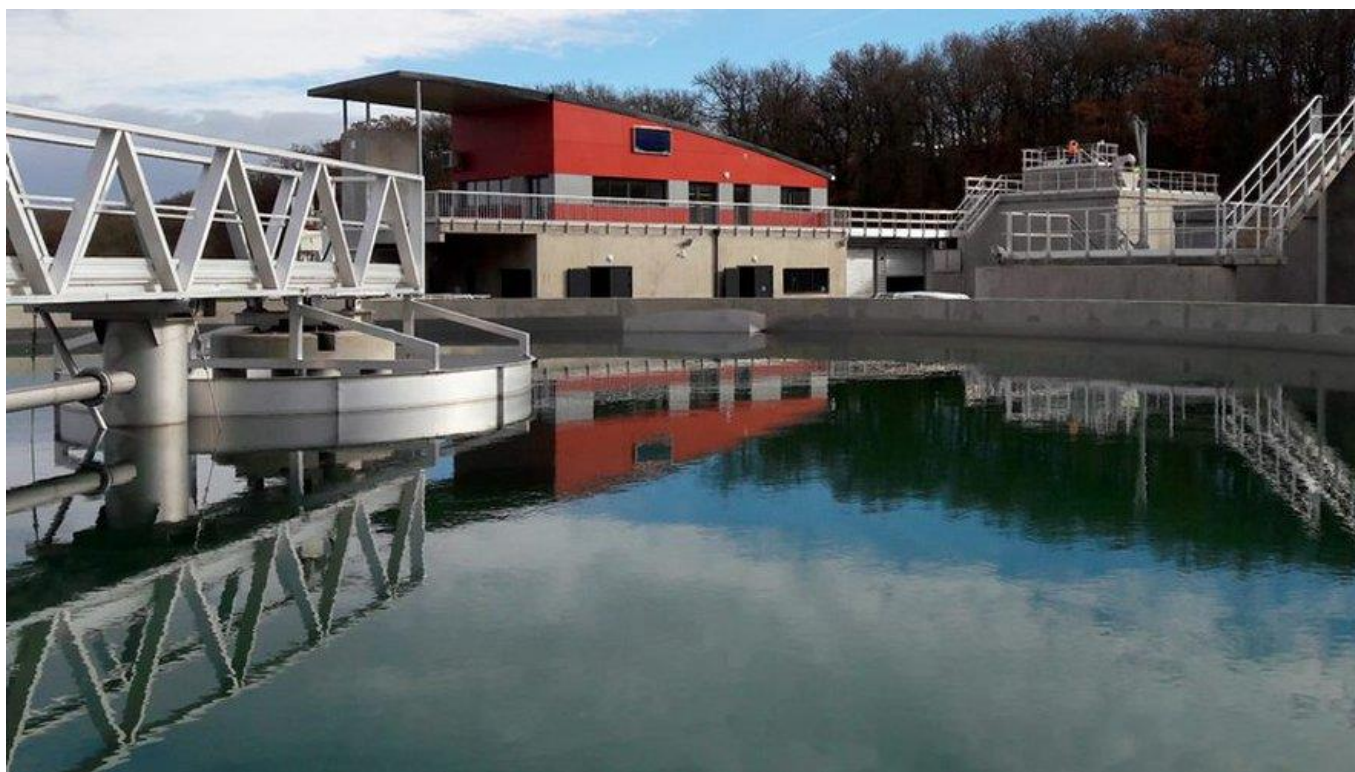
Illustration 32 : nouvelle station d'épuration de la Salvetat saint gilles
