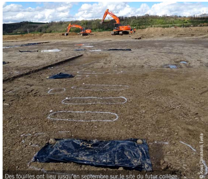
Des fouilles ont lieu jusqu'en septembre sur le site du futur collège.
