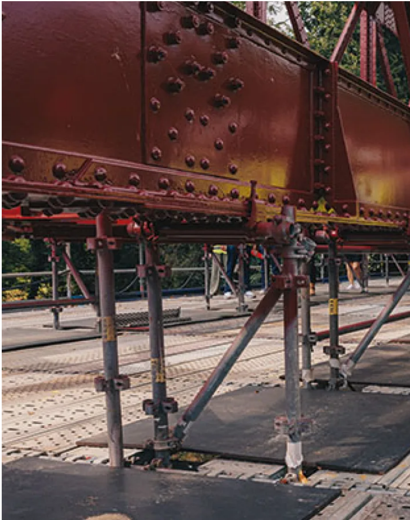
Aurélien Ferreira/CD31 Visite du Pont de Lacroix-Falgarde 17 juillet 2026
