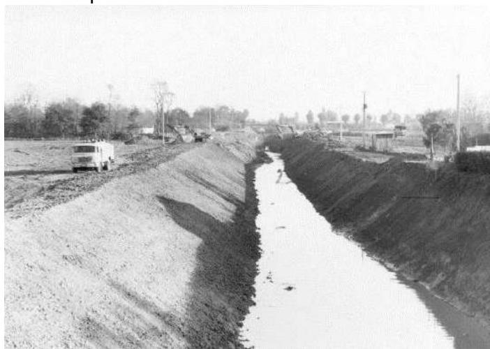
Illustration 26 : Photographie du recalibrage de l'Hers.
