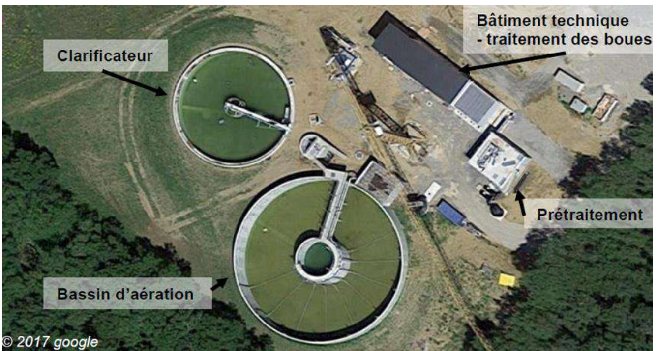
Illustration 37 : STEP de La-Salvetat-Saint-Gilles en cours de construction (source Google maps©)
